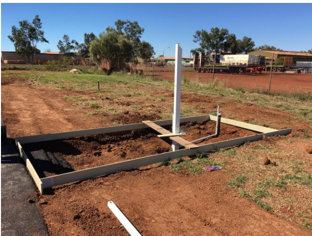
Figure A 14: Pre-concrete pour
