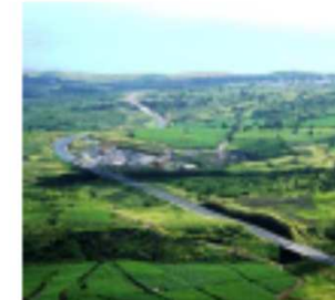
Route des Tamarins Lot chaussées nord 2007-2009
